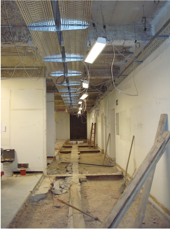
während des Umbaus
