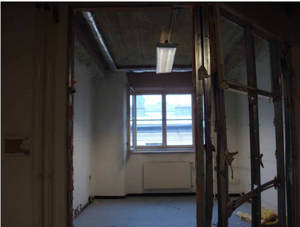
während des Umbaus
